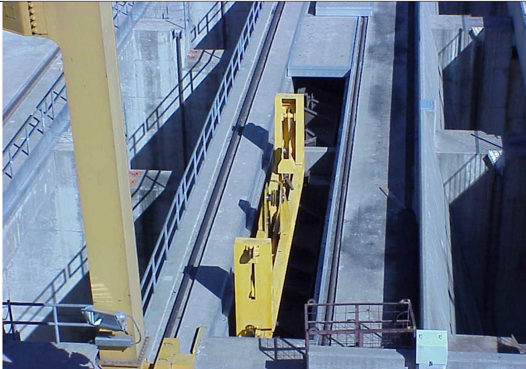
Figura 6. Grúa Pórtico/Viga Pescadora/ataguías
