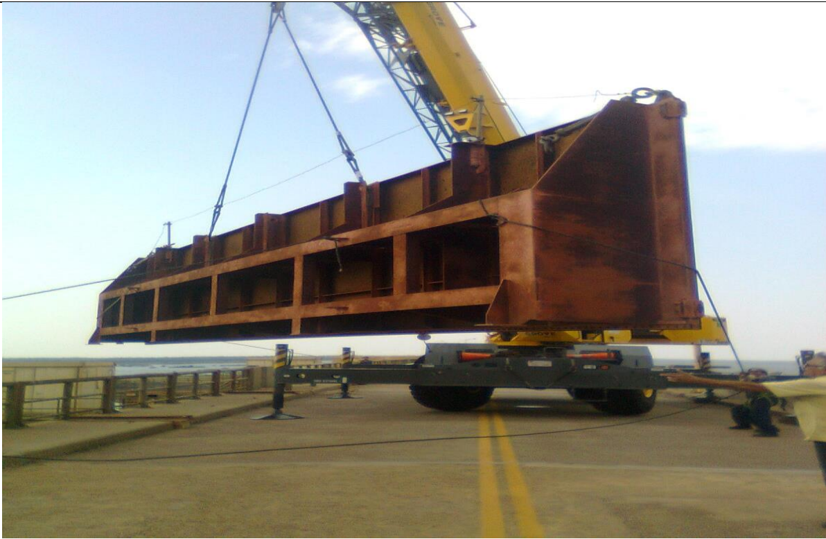
Figura 3. Grúa Móvil/Tumbado de ataguia
